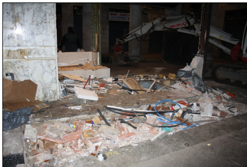
Fotografia 2. Enderroc de la parada162-168
